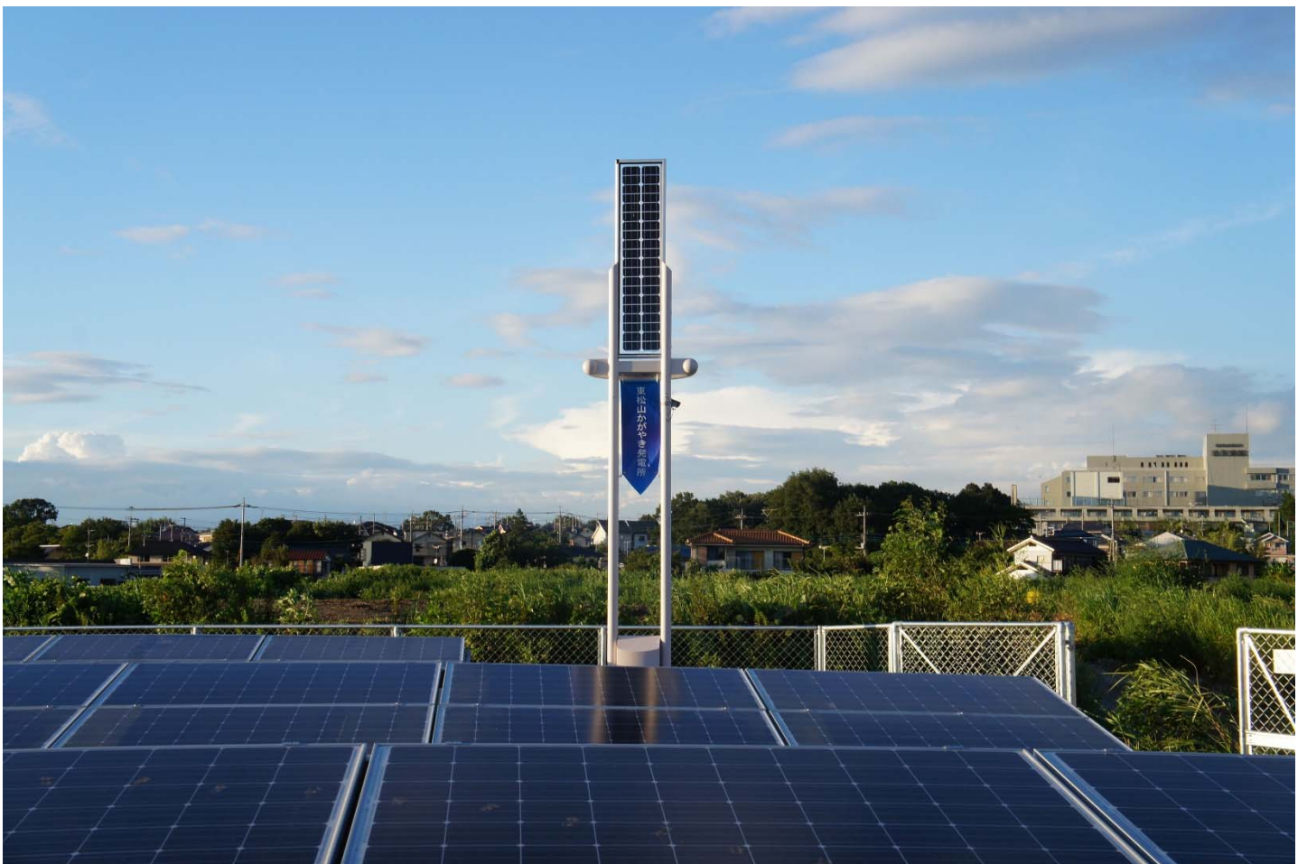
東松山かがやき発電所(埼玉県東松山市)
