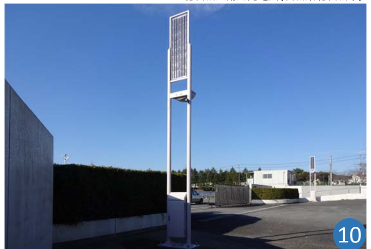
北茨城太陽光発電所(茨城県北茨城市)
