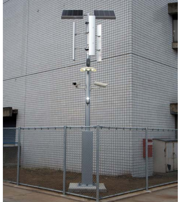
NTT東日本 武蔵村山局(東京都武蔵村山市)
