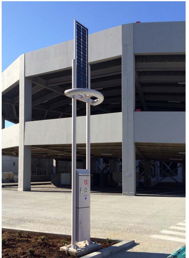
日本ロジスティクスファンド八千代物流センター(千葉県八千代市)
