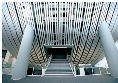
<下：渋谷ヒカリエ シアター入口の外装ルーバー>
