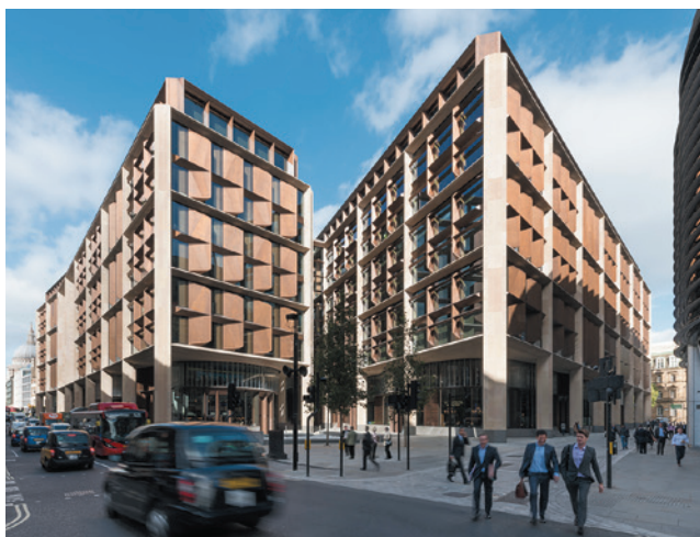
Bloomberg European headquarters (ブルームバーグ新欧州本社屋) 外装フィン (銅合金)
