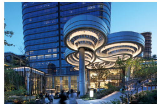
難易度の高い形状を実現した施工事例「麻布台ヒルズアリーナ大屋根」
