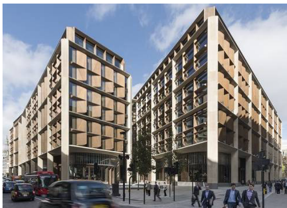
<RIBA スターリング賞を受賞した ブルームバーグ新欧州本社ビル外観>
