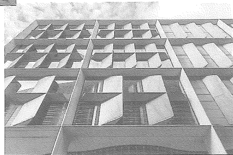
写真-1 ブルームバーグ新欧州本社屋外観と外装フィンパネル
