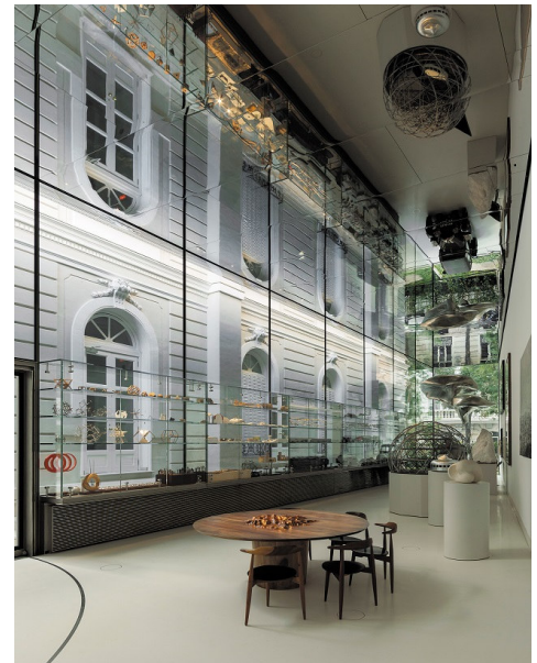
<「The Pavilion」のステンレス鏡面パネル> 細目地や点検口の工夫で一体の鏡のような納まりとなっている
