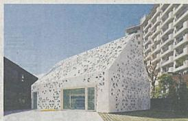
都市開発事業が活発化する中、建築物のデザインにも大きな注目が集まり、そこでは溶接技術や切断技術も大きな役割を果たしている。レーザ加工技術もその一つ。東京ミッドタウン（六本木）の「EQ House（EQハウス）」では、出力4kwの炭酸ガスレーザによって板厚3mmのアルミニウムパネル1200枚を切り抜き加工。創意工夫によって建築パネルのような大型部材に同パネルの適用を実現した（アルセラ・ベンツと竹中工務店がコラボレーションした未来のモビリティリビングの形を実現化した体験施設）〔写真①外観、同②内部〕
