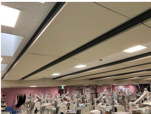
<輻射天井施工後の練馬桜台クリニックの様子>
