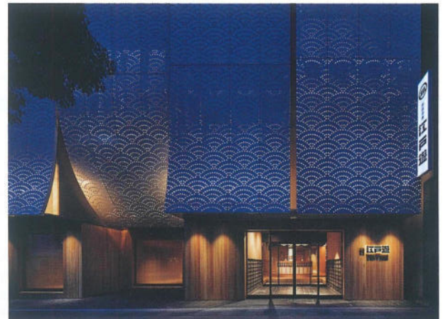
夜景。パンチングパネルを通し、青海波の模様が浮かび上がる
