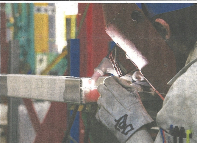
駅に使用された部材の溶接(菊川工業工場)
