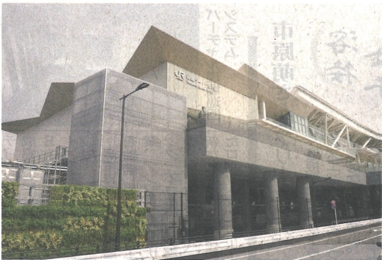
高輪ゲートウェイ駅舎(大屋根の金属部品・デッキ側面の幕板パネルとその下部の丸柱パネルを菊川工業が担当)
