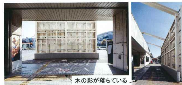
写真-8 改札側から見た新設防風壁
